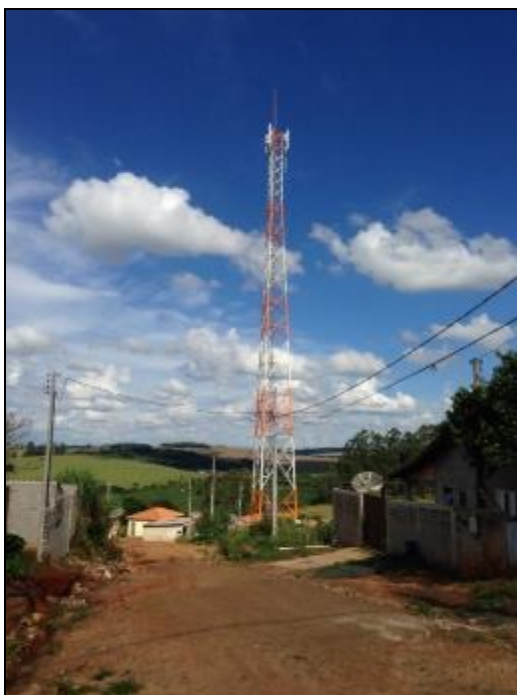
Figura 5.11 - Torre de transmissão de telefonia móvel - Operadora TIM
