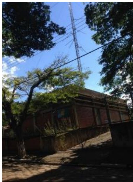
Figura 5.10- Torre de transmissão de telefonia móvel- Operadora Oi
