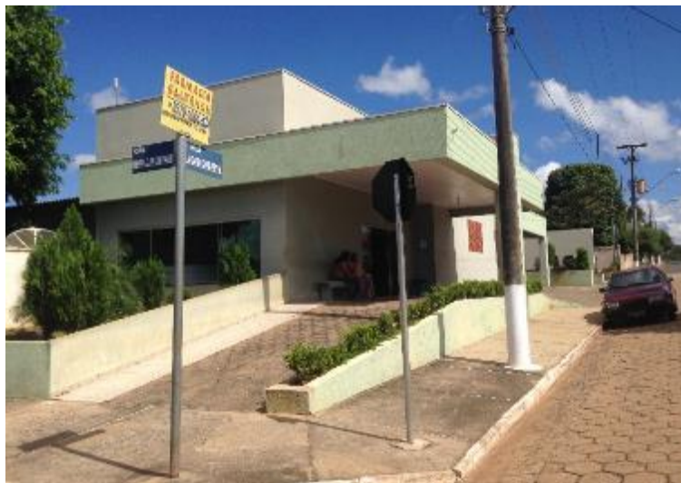
Figura 6.1 - Hospital Municipal de Salto do Itararé
