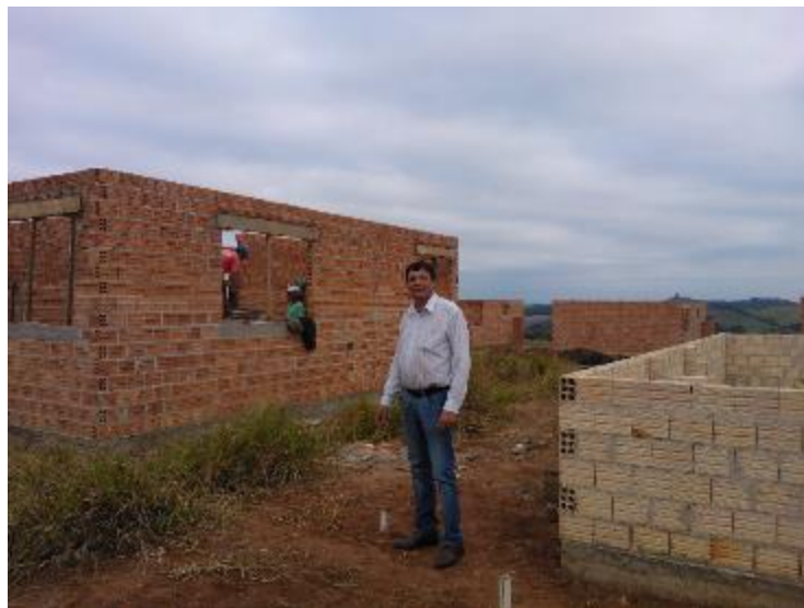
Figura 4.14 – Canteiro de obras das Unidades Habitacionais no Bairro Marimbondinho
